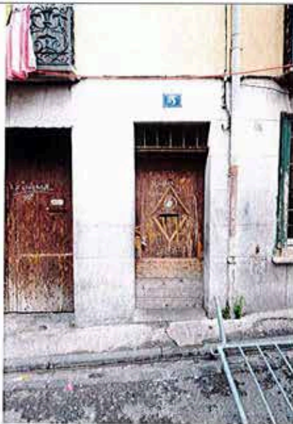
Détail de la porte d'entrée
