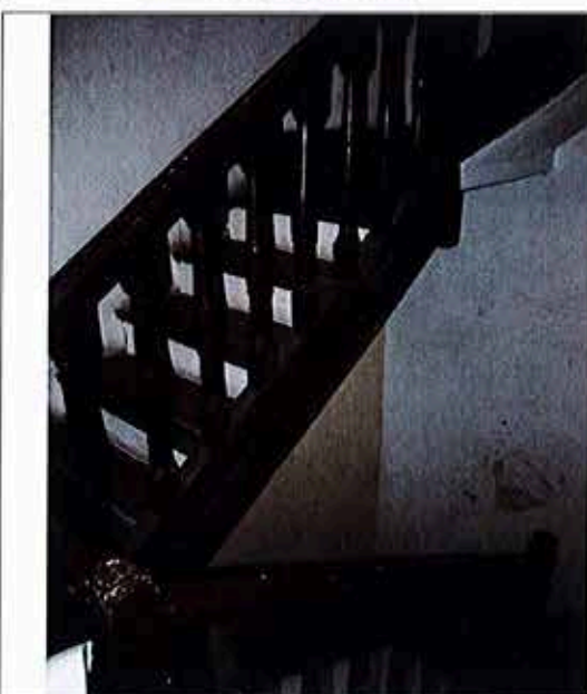
Escalier à cage vide au centre de la parcelle
