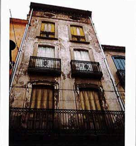
Baie avec encadrement à crossette
