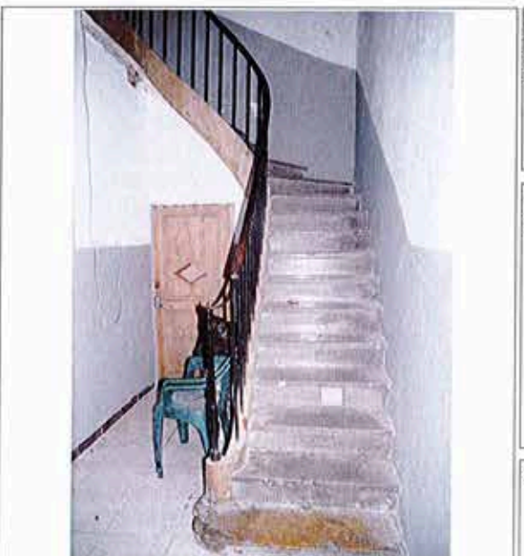
Première volée de l'escalier Est
