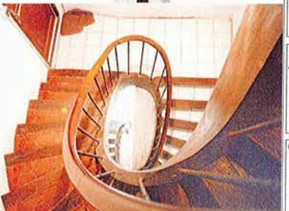
Escalier - Premier palier, deuxième volée
