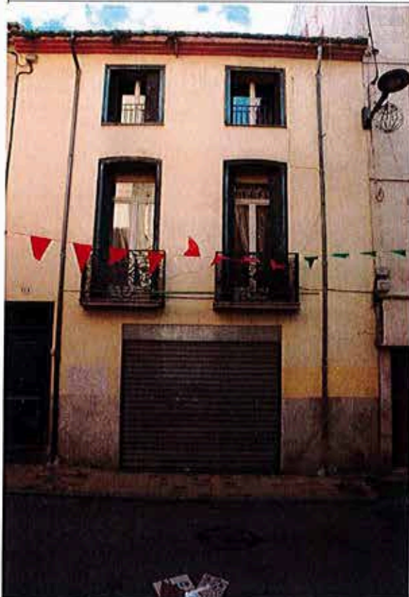
Façade sur rue Lluçia
