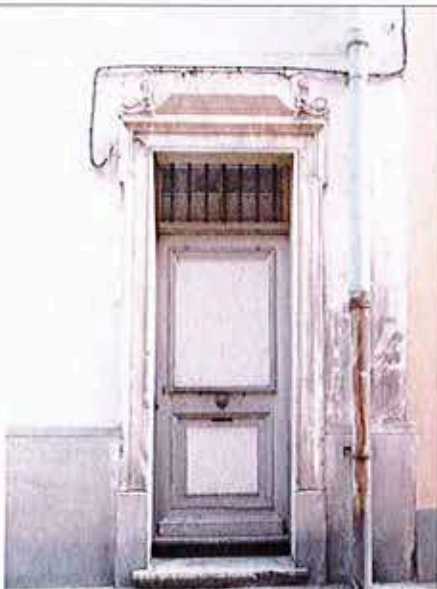
Détail encadrement porte d'entrée
