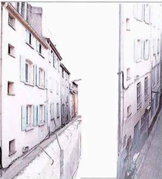
Rue de la Poissonnerie
