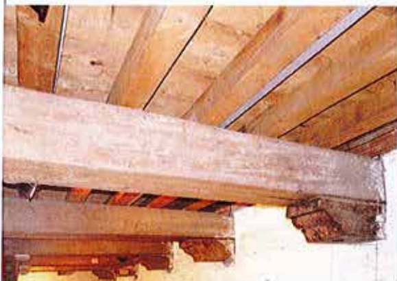
Vue du plancher de la Poudrière
