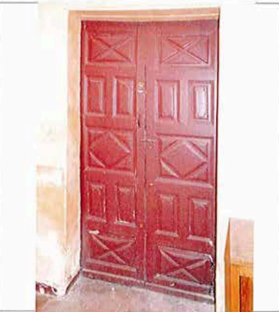
Porte du palier du 1er étage
