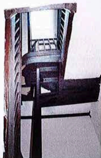
Cage d'escalier en contre-plongée
