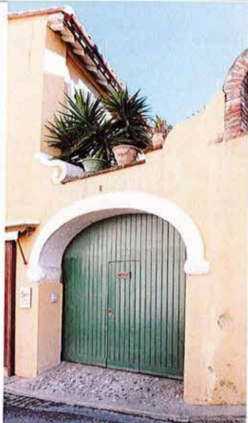
Rue du Four Saint-Jacques: porte cochère.
