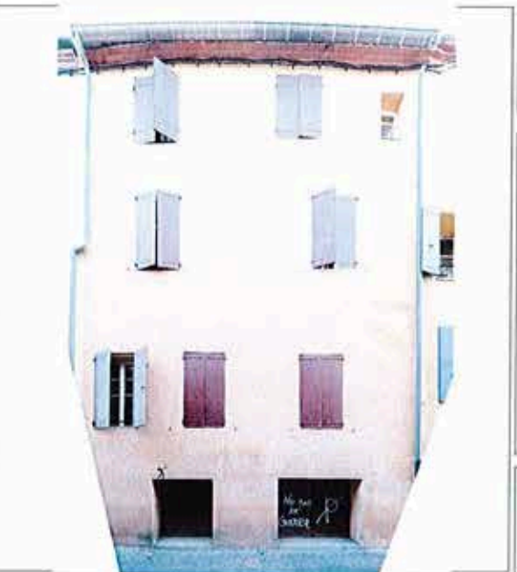
Façade rue du Ruisseau - Entrées de garages
