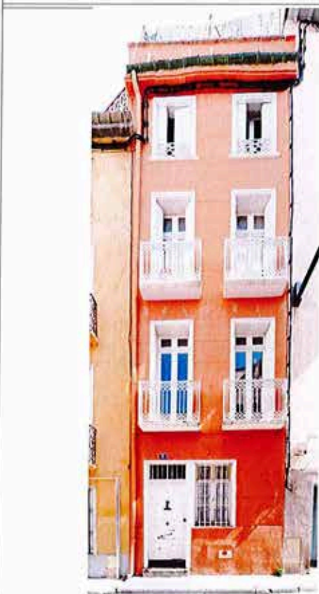
Façade rue du Ruisseau
