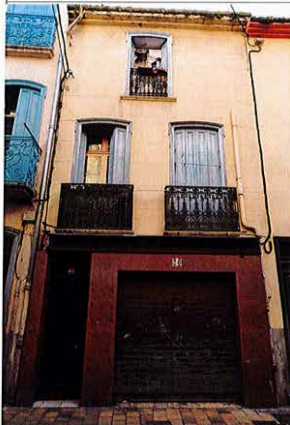
Façade sur rue Lluçia
