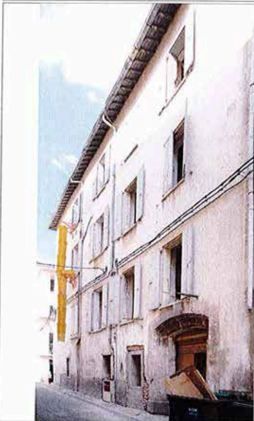
1, rue Porte de Pierre
