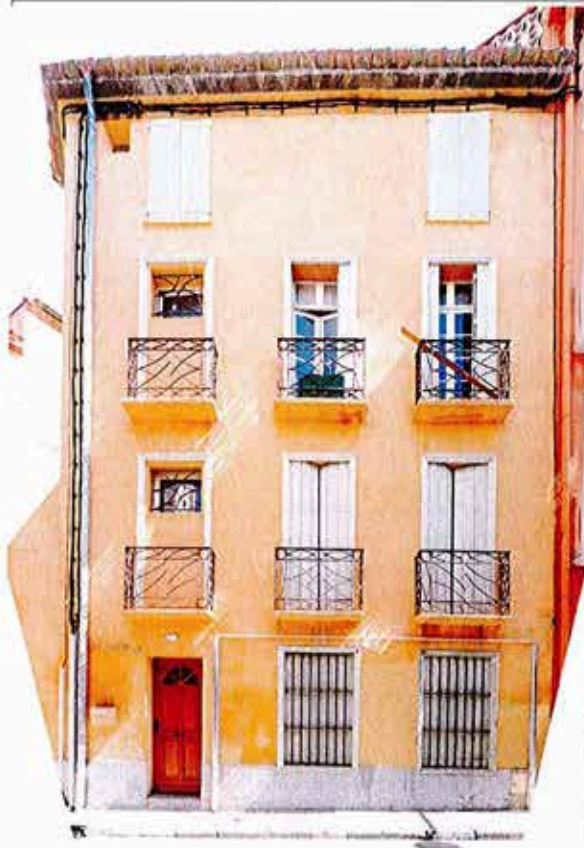
Façade rue du Ruisseau
