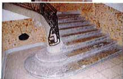
Galerie sur cour et départ d'escalier
