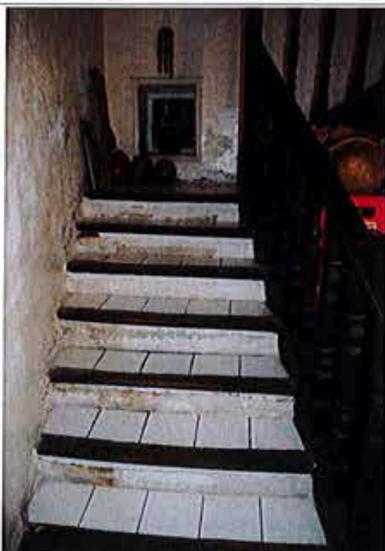
Volée droite d'escalier
