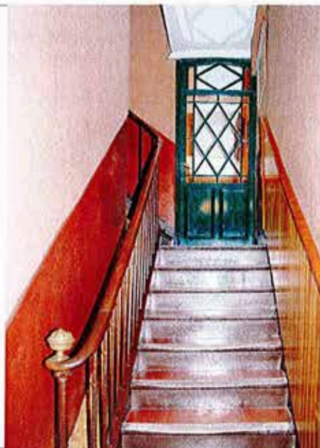
Escalier - Départ de la première volée
