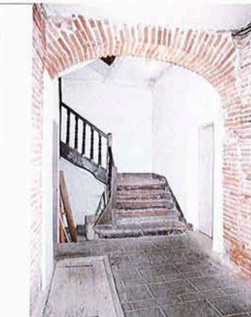
Entrée de l'immeuble
